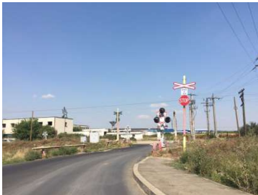
Figura 2.6.3 Trecere la nivel cu cale ferata (trecere 2)
