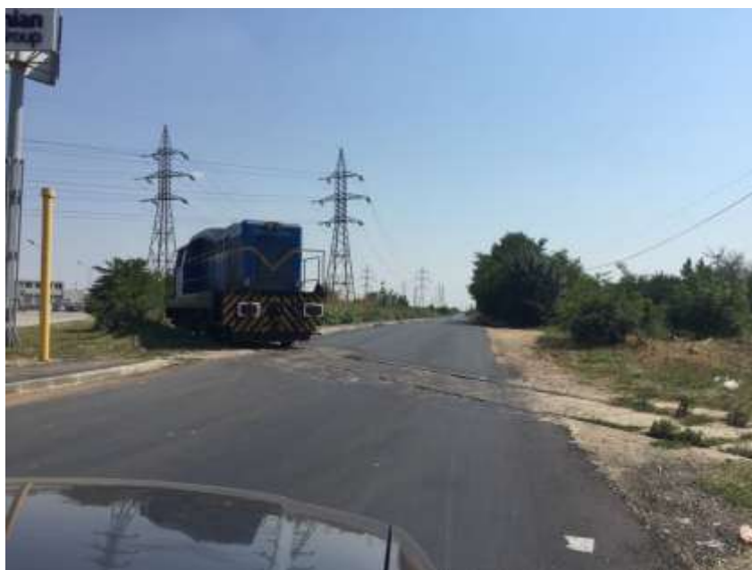
Figura 2.6.2 Trecere la nivel pentru aprovizionare (trecere 1)
